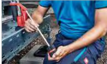
2. Escariar la parte externa del tubo
