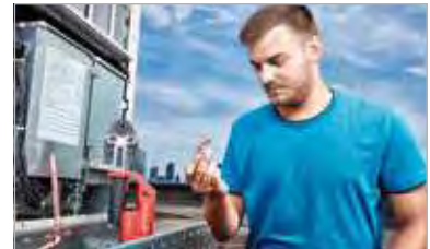
6. Asegúrese de que la junta tórica está asentada
