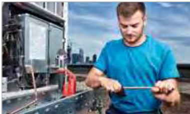
7. Marque la profundidad de inserción con el medidor de profundidad e inserte el tubo completamente en el ajuste
