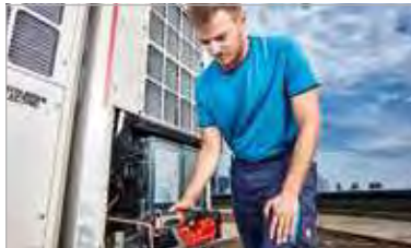
8. Alinee las mandíbulas directamente sobre la conexión y complete la junta
